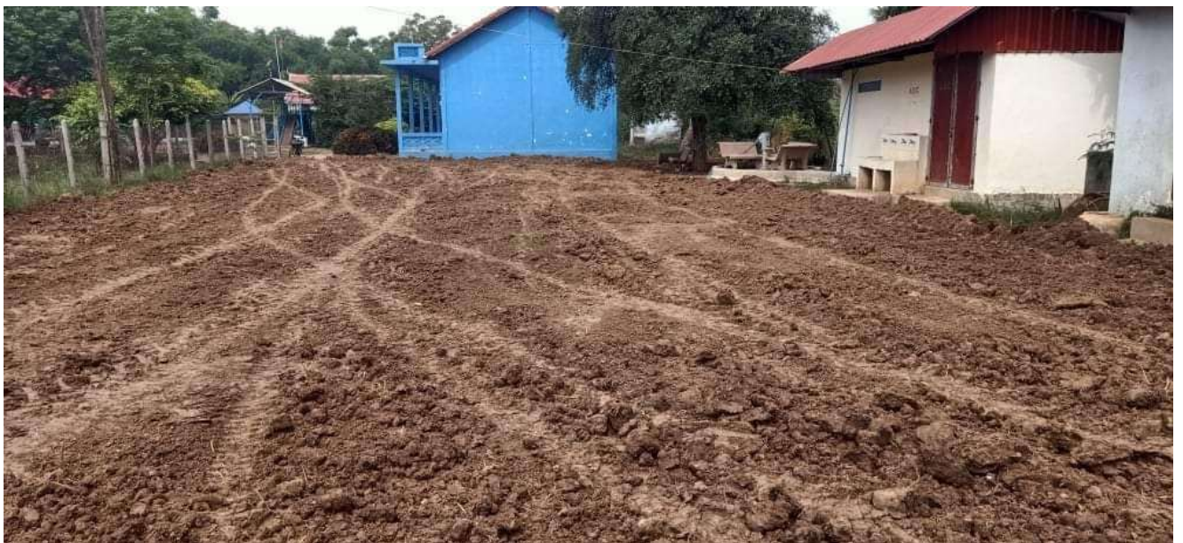
Terrassement pour mieux gérer la montée des eaux
