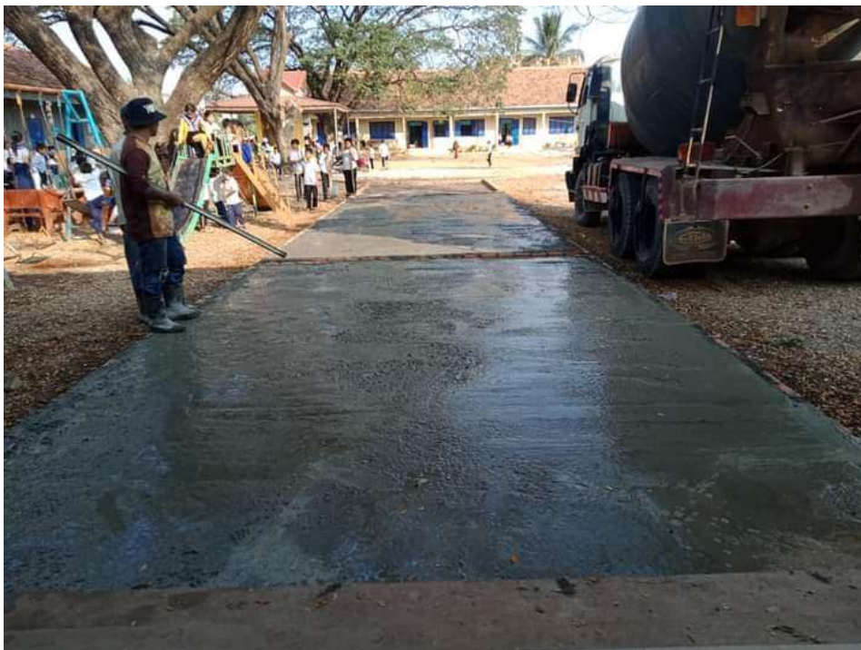
Gros travaux pour les nouvelles allées cimentées !
