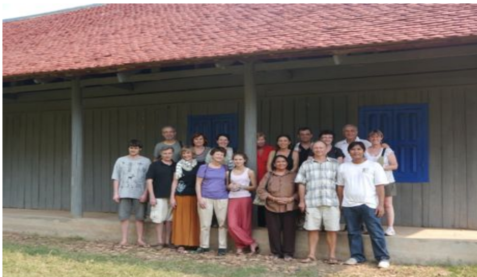
La "délégation" de Monireth devant le bâtiment rénové de l'école de Phum Thmei
